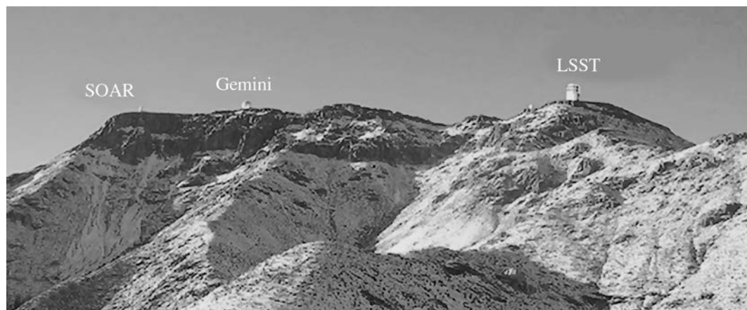
Место строительства телескопа LSST на горе Серо-Пачон в Чили рядом с Обсерваториями Мауна Кеа и Южной астрофизической. Фото Обсерватории LSST .
